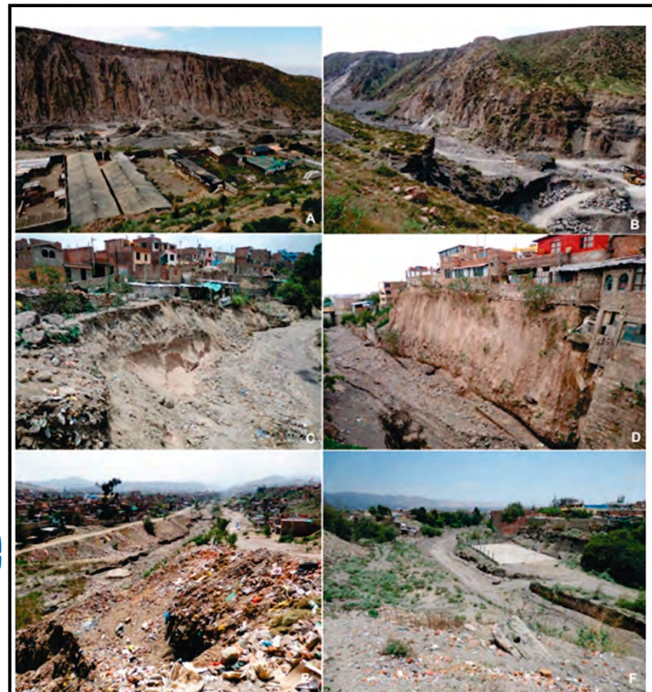
Figura 6.35 a) erosión en cárcavas y derrumbes en ambas márgenes de la quebrada San Lázaro (parte alta), aportan material suelto al cauce de la quebrada; b) presencia de canteras en el cauce de la quebrada San Lázaro, acumulan material suelto; c y d) viviendas ubicadas en el borde del acantilado, formado en la quebrada San Lázaro, algunas ya han colapsado; e) desmonte y basura acumulada en la parte alta de la quebrada San Lázaro; f) plataforma deportiva en terraza baja de la quebrada San Lázaro.
